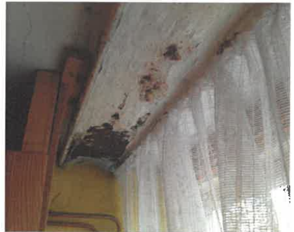
Bærende bjælke over kældervindue.
