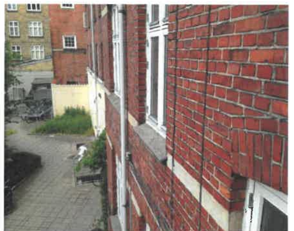
Arbejdet skal udføres fra stillads.
