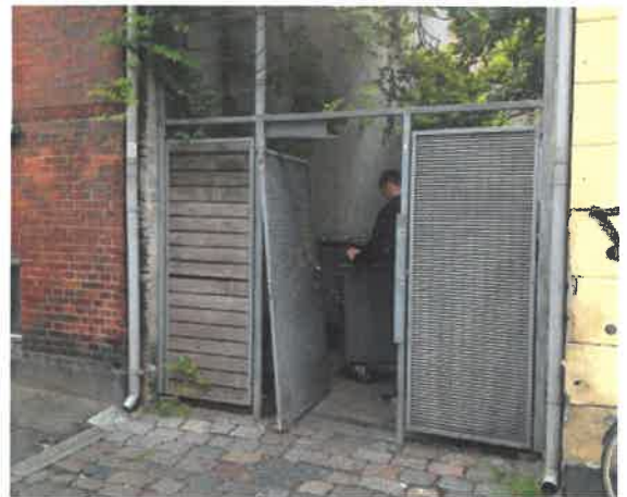
Destruktiv åbning i kælder
