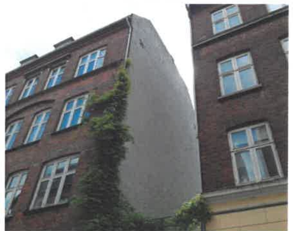
Gavlen her er oplagt at få efterisoleret.
