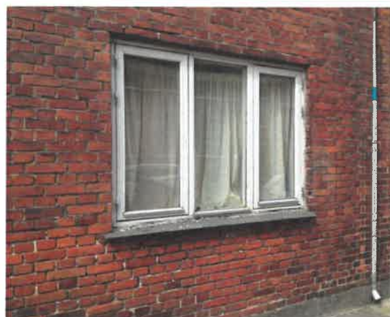
Vinduet trænger til udskiftning, og ikke mindst fugeme omkring.
